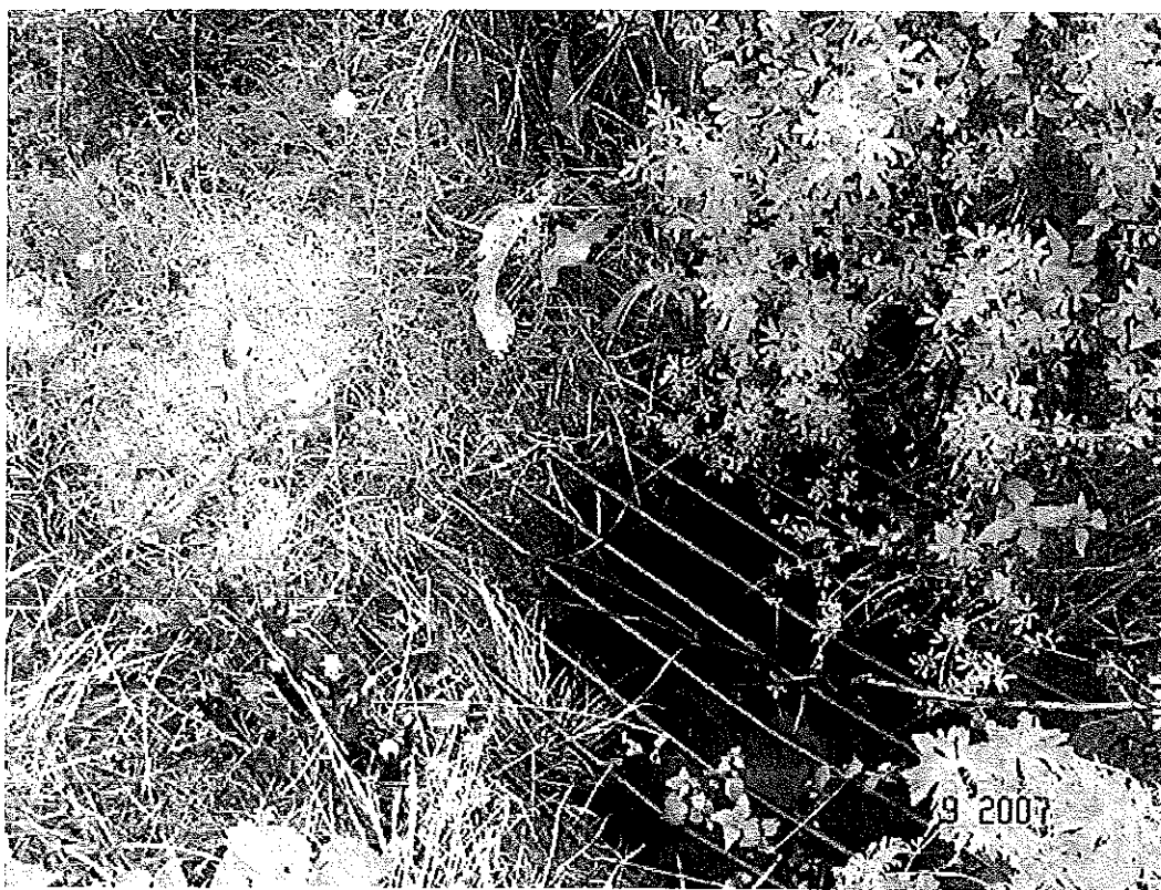
Počátek dešťové kanalizace představují tzv. lapače, opatřené česlem proti ucpaní. K tomu však při smyvech půdy pravidelně dochází.
