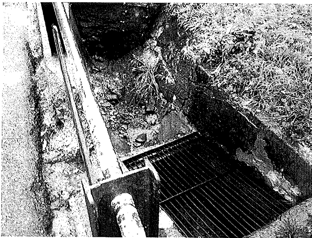
Příkopy a svodnice jsou dnes většinou nahrazeny dešťovou kanalizací (Pačlavice)
