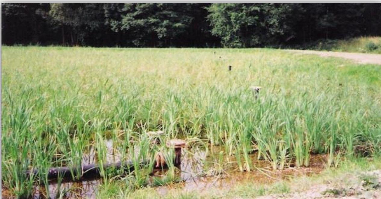
Kořenová čistírna odpadních vod v Osové Bítýšce – první svého druhu na Moravě
