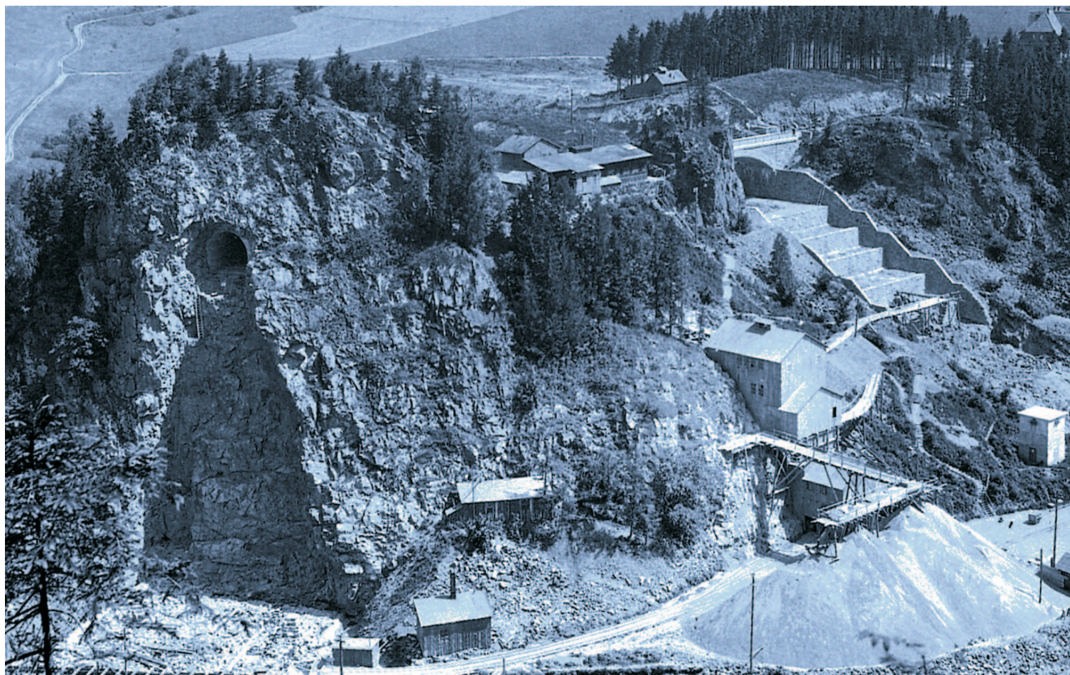
Výstavba přehrady Seč na Chrudimce, rok 1928.
