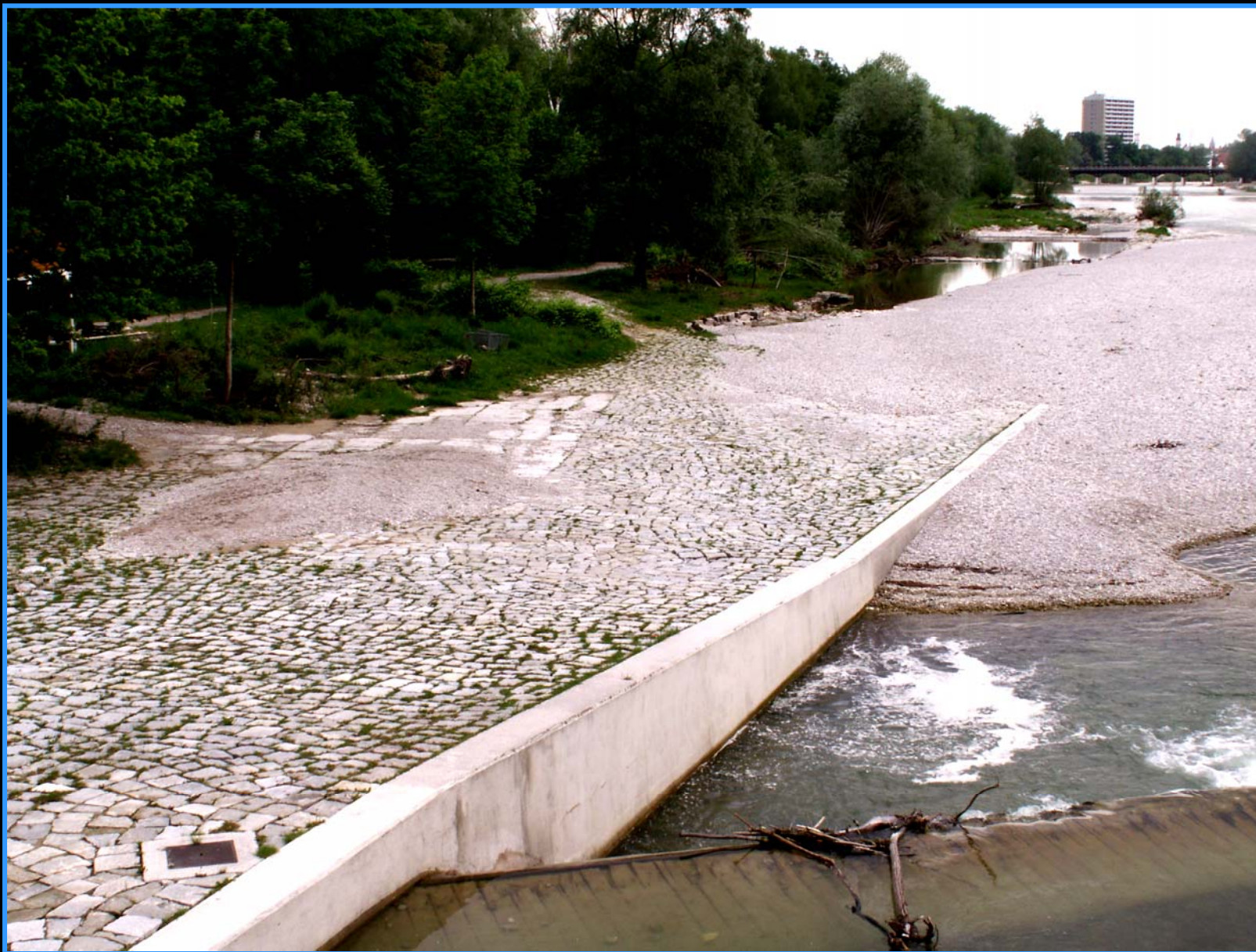
Rekonstrukce a vyšší míra zajištění stávajícího systému ochranných hrází po obvodu rozšířeného říčního koridoru (na snímku ukryty ve stromové zeleni). Viz též následující snímek
