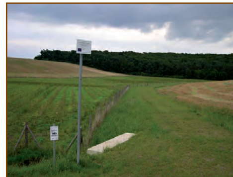
Obr. 3.20 Ochranná hrázka (Hlubočany)
